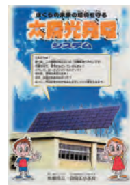
札幌市立西岡小学校太陽光発電システム
