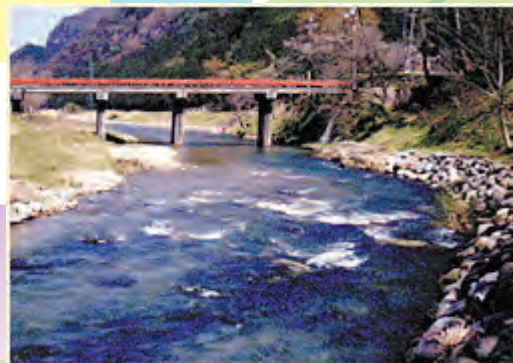
●多自然型川づくり(八東川、鳥取県八頭郡若桜町)
