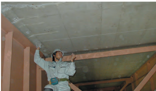
点検作業のようす
