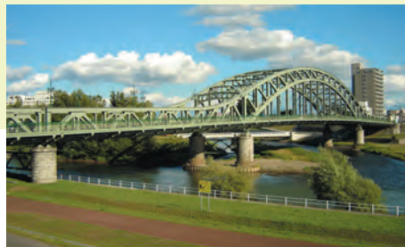
この橋は昭和7年に建設された旭川市の旭橋です。これまで何度かの補修を経て今でも使われています。
