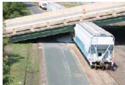
貨物列車の上に橋が落ちた例(海外)
