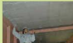
詳細な方法による点検の様子
