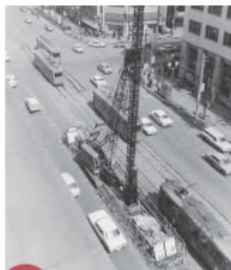
地下鉄 地下鉄工事(昭和44年) [札幌市写真ライブラリー所蔵]
