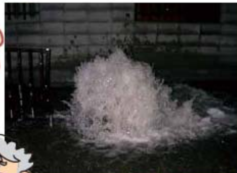
破裂した上水管 [提供:札幌市]
