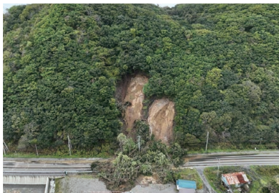
一般国道336号様似町鶴苔 土砂崩壊による国道の被災(2023年10月)
